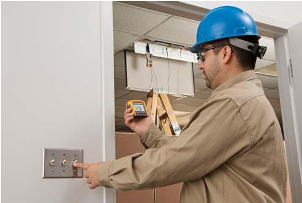
Multímetro TRMS FLUKE 233en la comprobación de una instalación eléctrica
