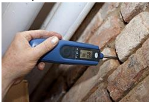
Medidor de humedad de equilibrio Hydromette BL Compact RH-T durante la aplicación en una junta de muro
