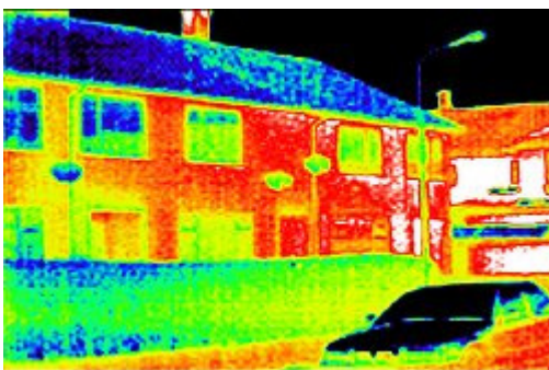
Otra presentación de color de la fachada del edificio
