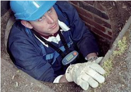
Protección personal en la revisión del alcantarillado.
