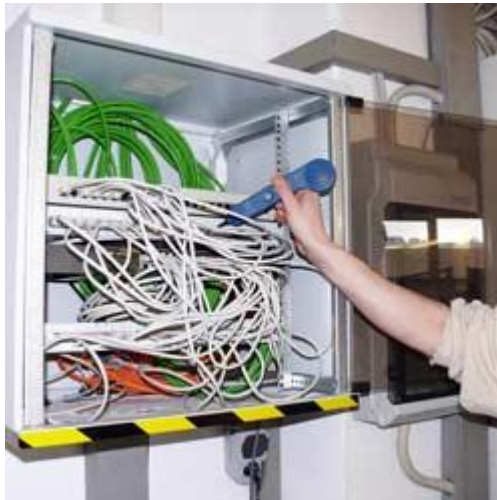
Reconocimiento de los cables de red en una estación central con el PCE-180 CBN.
