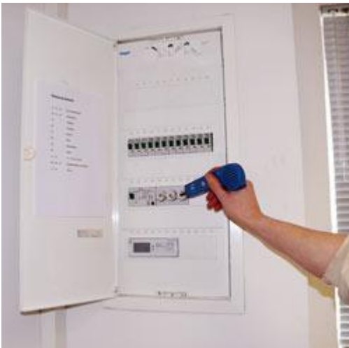
Búsqueda para verificar qué cables pertenecen al circuito eléctrico con el PCE-180 CBN.
