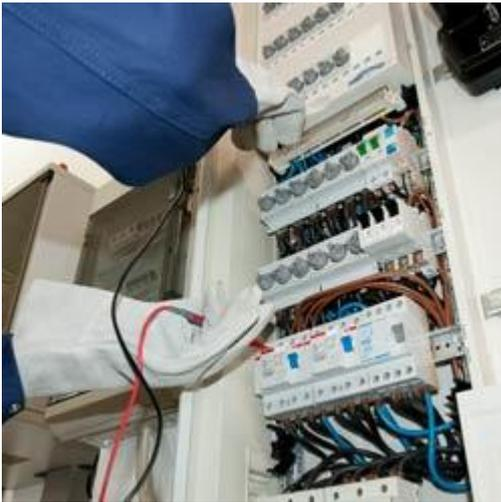
Medición de tensión con la pinza amperimétrica de maxilar abierto
