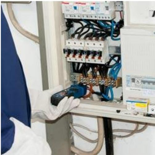
Medición de corriente en un armario de distribución con la pinza amperimétrica de maxilar abierto
