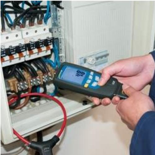
Medición de frecuencia con la pinza amperimétrica flexible
