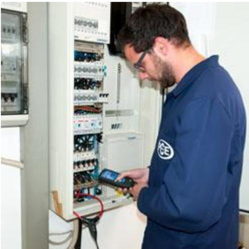
Uso de la pinza amperimétrica flexible
