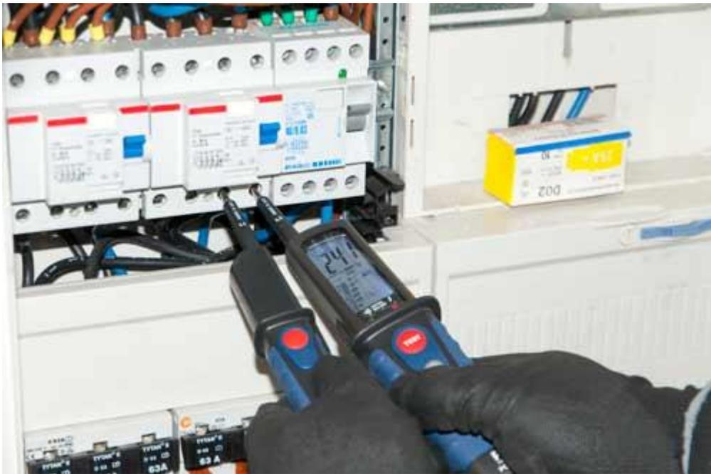
El comprobador de tensión PCE-TR 2 comprobando un armario de distribución
