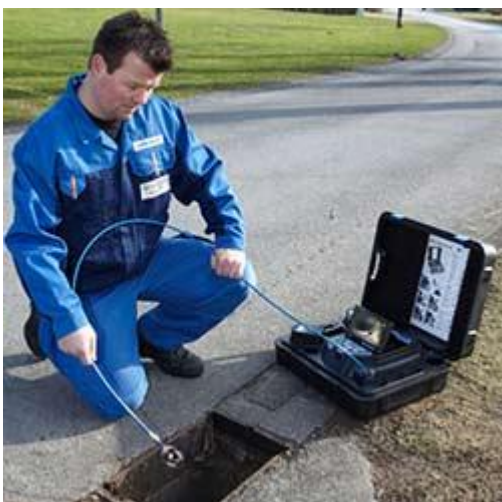
Aquí puede ver el endoscopio localizando daños, p.e. una localización en un sistema de canal
