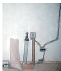
Encuentre las líneas sin tener que agujerear o levantar la pared
