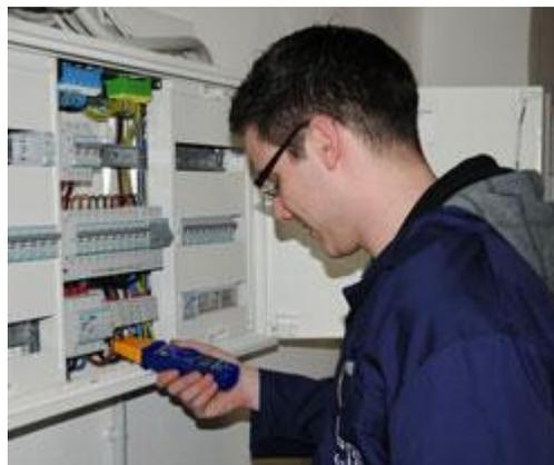
Aquí observa como se mide con la pinza amperimétrica la corriente en un armario eléctrico.
