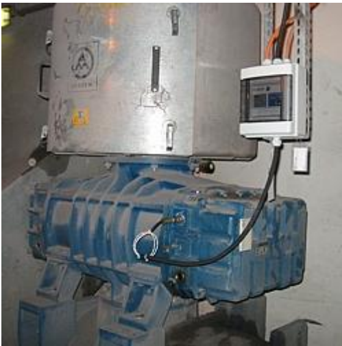
Aquí se observa el monitor de vibraciones controlando una máquina de vibraciones
