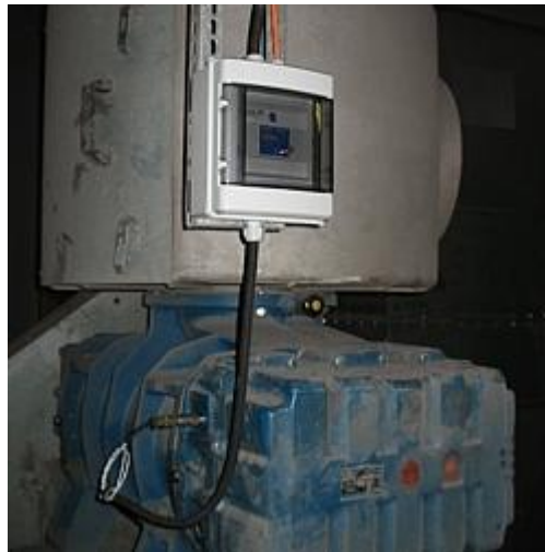
Aquí ve el monitor de vibraciones controlando una máquina de compactación
