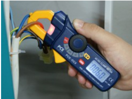
Amperímetro PCE-DC3 detectando la tensión del cable de una instalación eléctrica.
