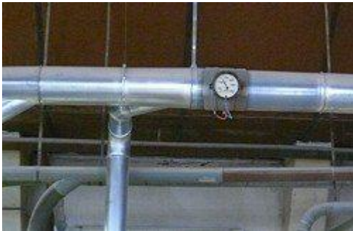
Aquí observa el tubo venturi PCE-VR instalado en una tubería.
