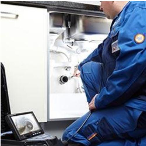
Comprobación de las tuberías en una bajante de una cocina con el endoscopio.
