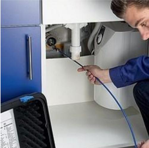
Con el endoscopio podrá localizar averías, por ejemplo en una red de alcantarillado, en bajantes en los edificios.
